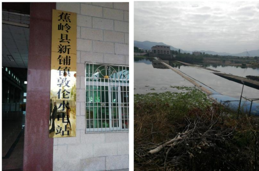
新铺水电站现状图片
