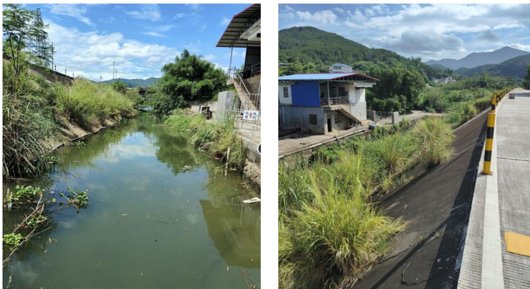
杨梅坑渠道及护岸现状
