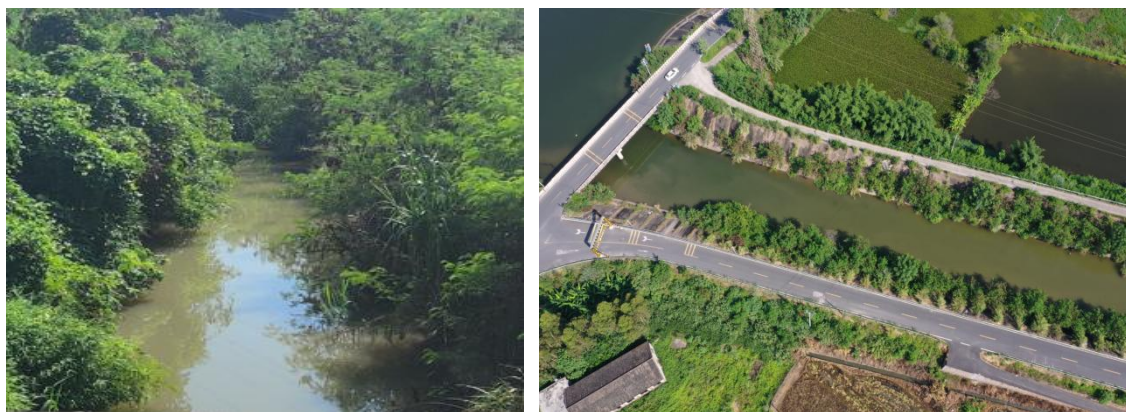
油坑河排口现状
