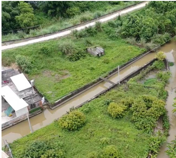
尖长排圳上游现状
