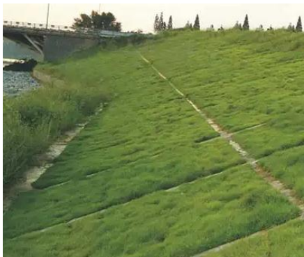
砼框格+三维植被网+植草护坡
