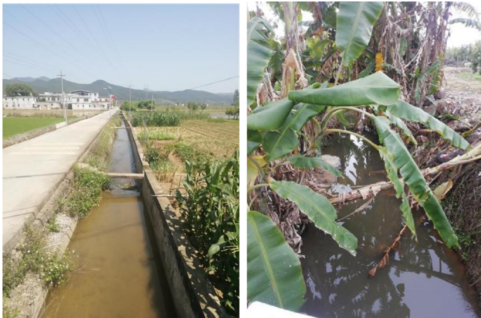
长江灌圳及河口渠现状
