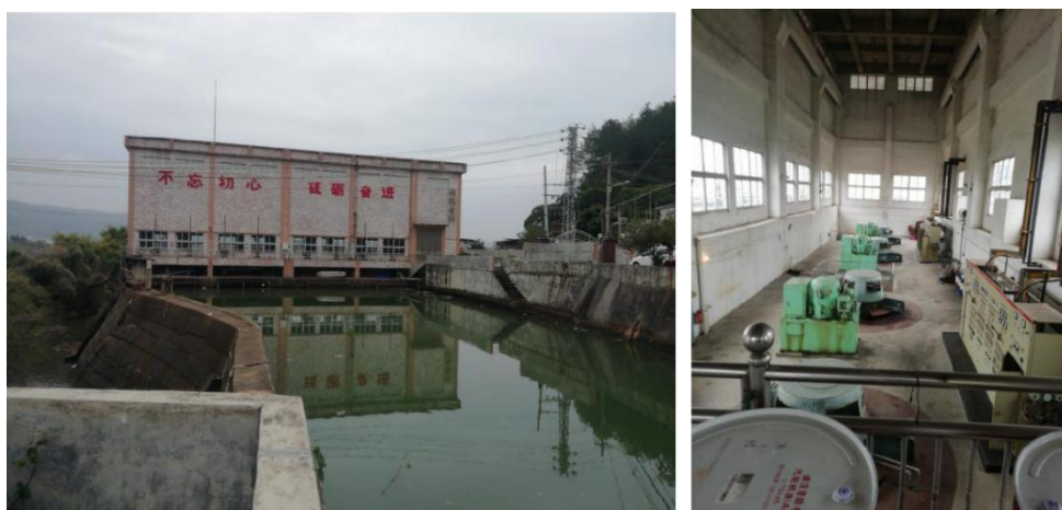
同福水电站现状照片
