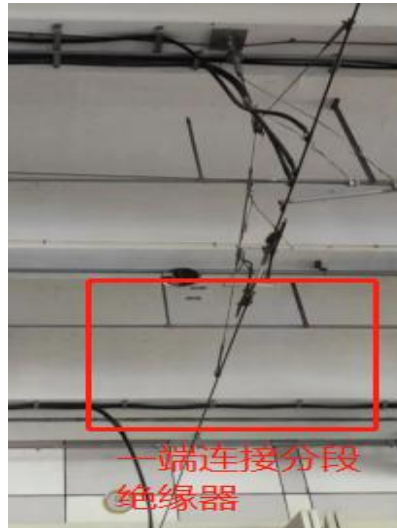
图4 小曲线锚段中间连接有分段绝缘器
