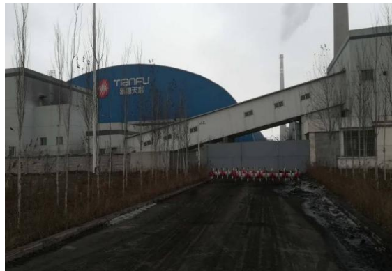
现有输煤栈桥
