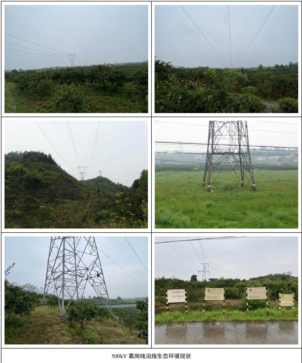
图 6-5 输电线路沿线生态环境现状实景照片
