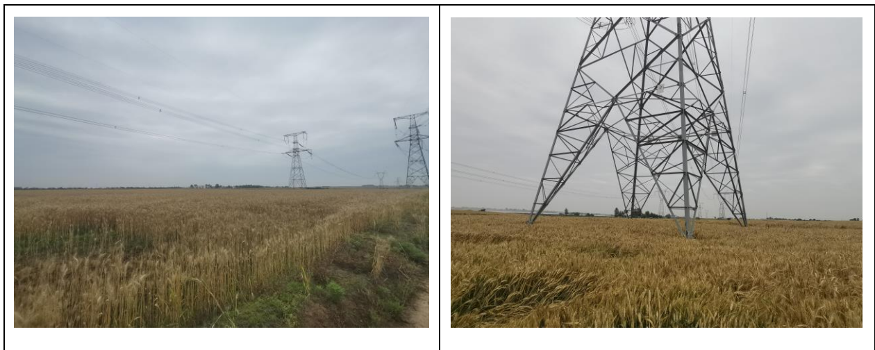
图 9-11 500kV 樊卧I线通过官沟水厂饮用水水源保护区实景照片
