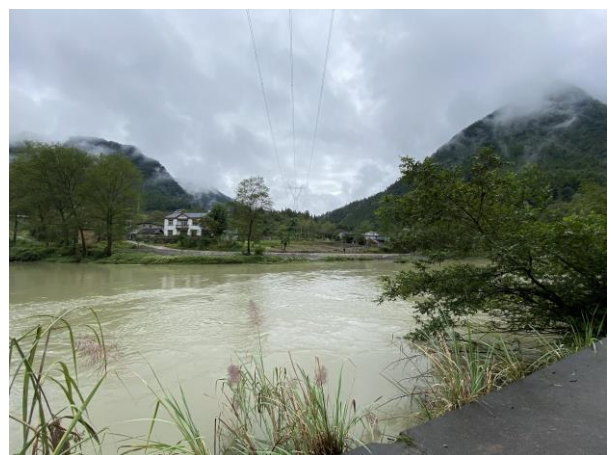
500kV 清葛线丹水河
