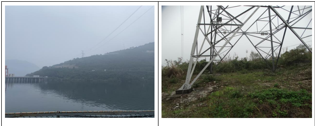
图 9-3 500kV 清葛线通过隔河岩水库饮用水水源实景照片
