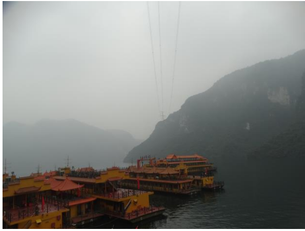
500kV 清葛线跨越清江
