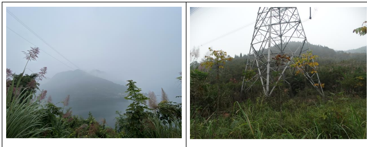
图 6-2 500kV 清葛线通过长阳清江省级风景名胜区实景照片
