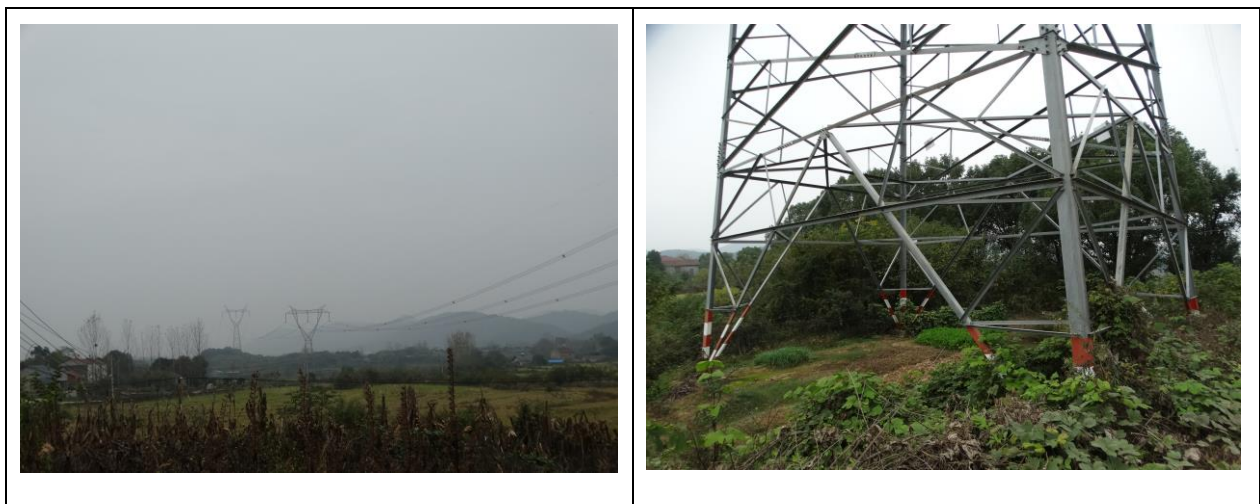
图 9-5 500kV 双玉 II 线通过惠亭水库饮用水水源保护区实景照片
