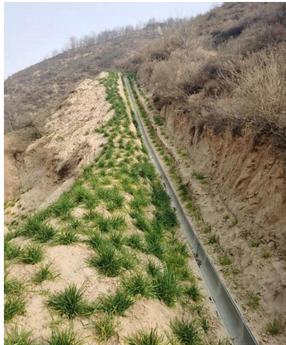
地表裂缝回填及治理
