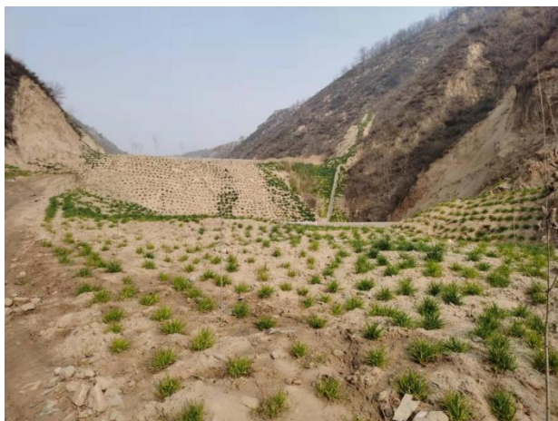
地表裂缝及滑坡复垦现场（填平裂缝、平整土坎、播撒草种）
