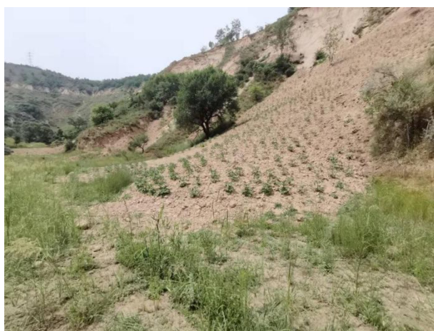
地表裂缝及滑坡复垦现场（填平裂缝、平整土坎、播撒草种）
