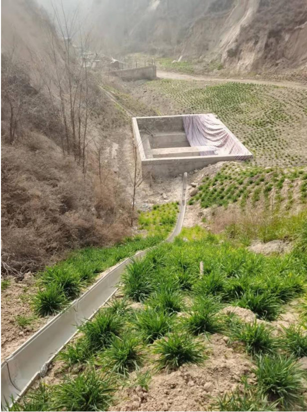
地表裂缝、塌陷坑回填及治理
