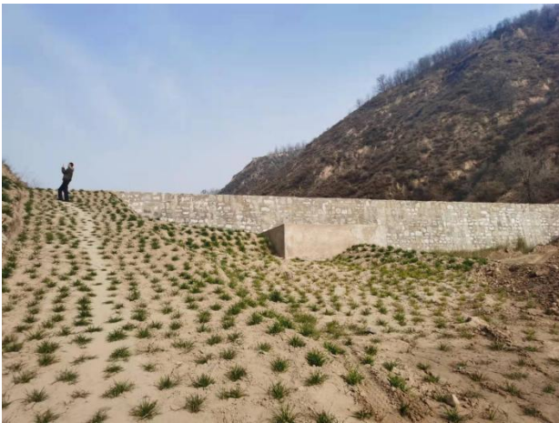
地表裂缝及滑坡治理
