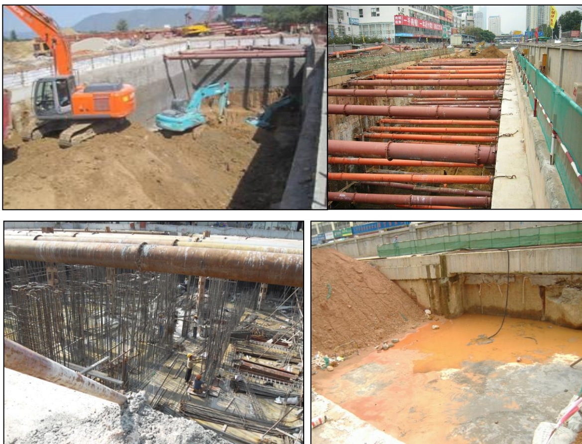
图 11.2-1 地下车站明挖施工过程照片
