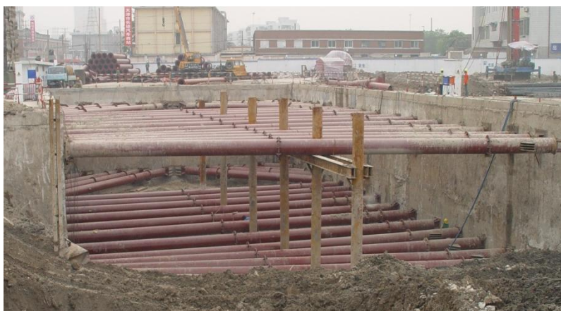
图 2.1-3 地下连续墙围护
