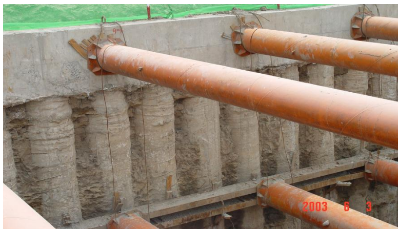
图 2.1-4 钻孔灌注桩+止水帷幕围护
