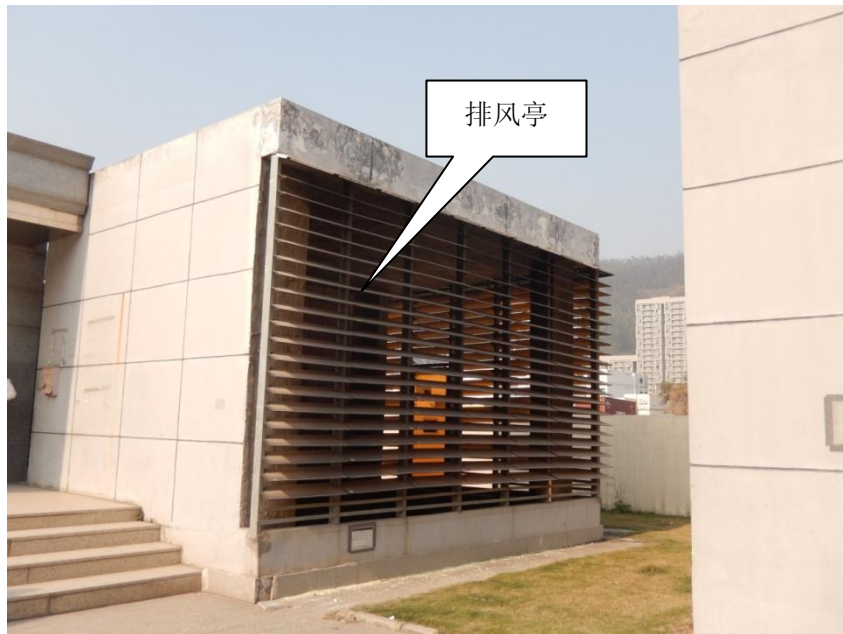
图 7.3-1 臭气浓度类比监测点（2 号线赤湾站排风亭外 5m 处）
