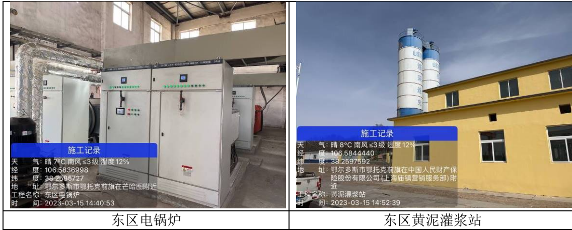
图 2.2-1 项目地面工程建设实景图
